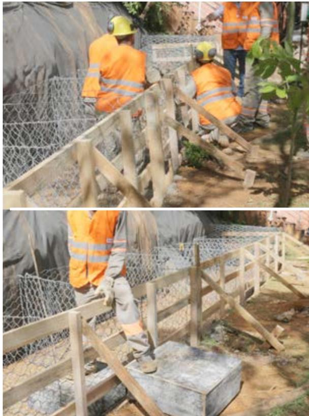
Elementos tipo caixas móveis de madeira para acesso ao interior das caixas
