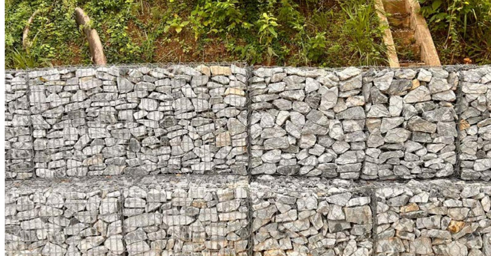
**Muro de gabião modular de malha soldada (gabião Easy S),**
