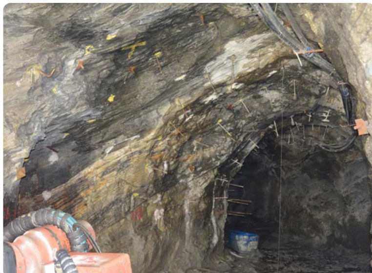
Cordoalhas para reforço do maciço rochoso
