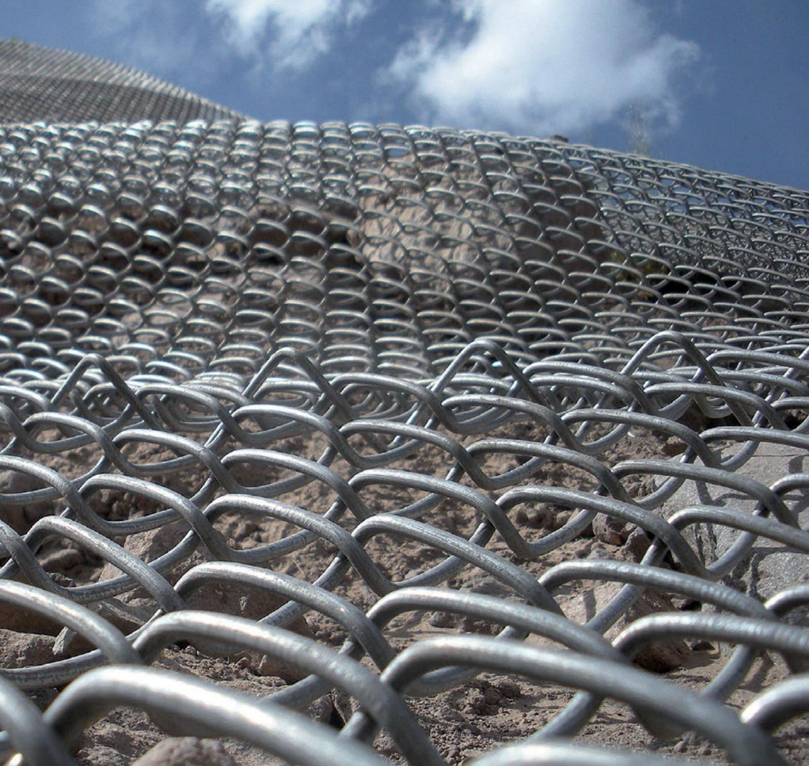
A malha talude (MT) faz parte de um sistema que pode ser configurado para o controle de desprendimentos de blocos rochosos e/ou para a estabilização de taludes.
