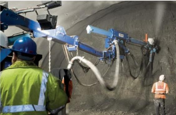
Concreto projetado para revestimento de túneis e taludes
